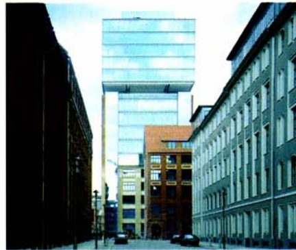
Aufgestocktes Turmhaus, Schweger und Partner
